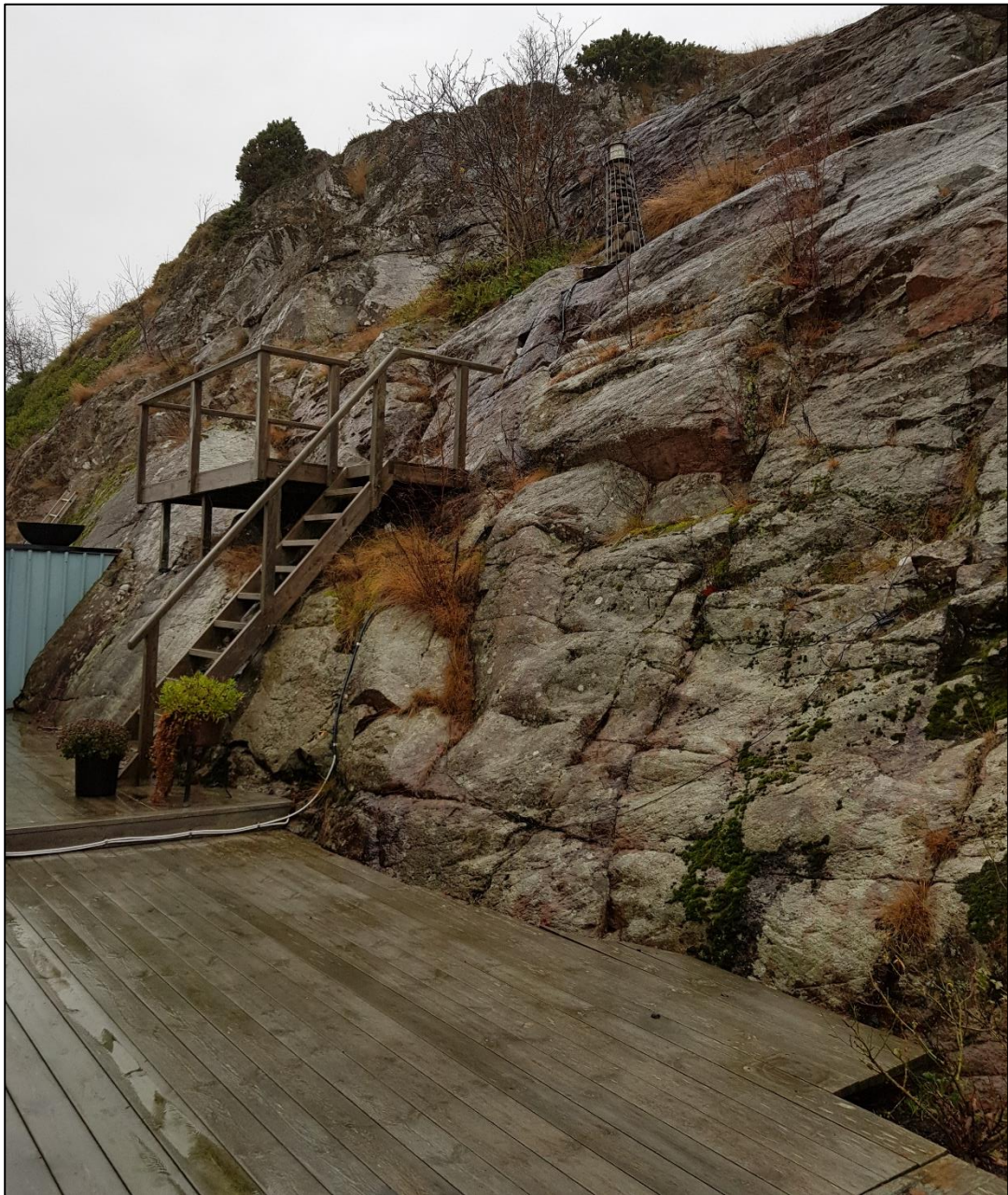
Figur 6. Befintliga fastigheter ligger i direkt anslutning till bergslänten.
