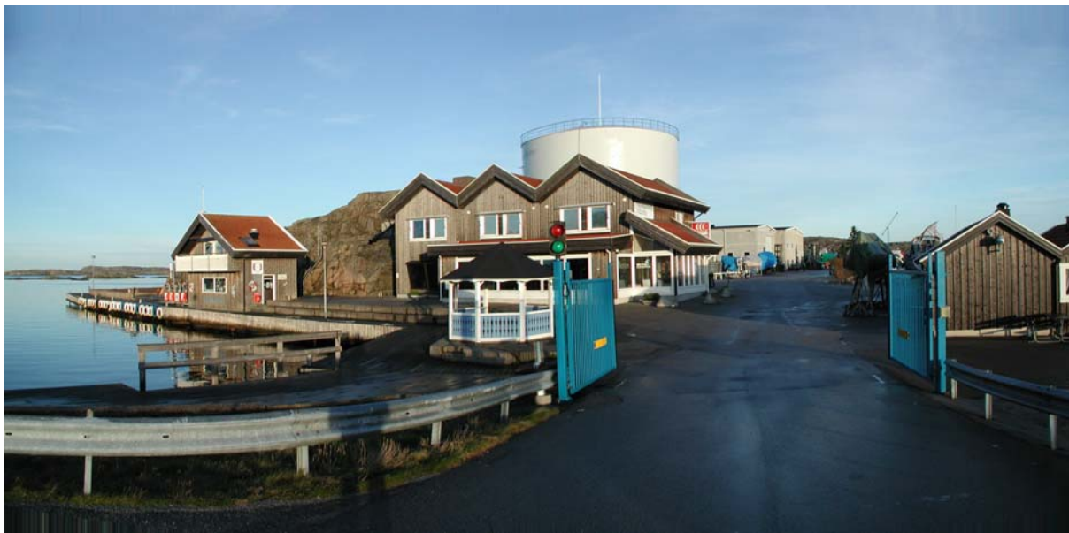
bild 5 – huvudinfart med kontor- och försäljningsbyggnad – drivmedelförsäljning längst till vänster i bild
