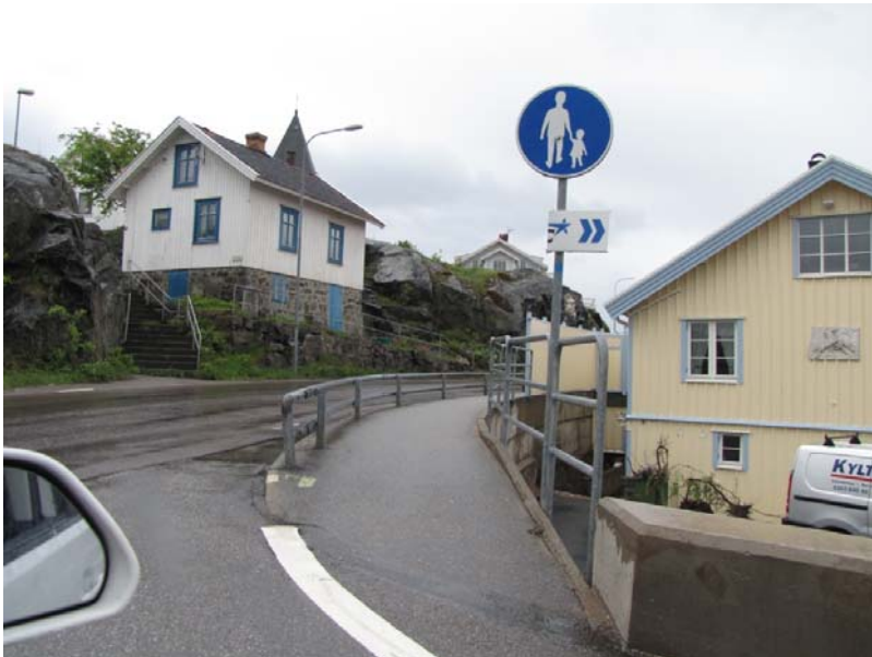
Figur 13 Anslutning av målad gångbana till gångbana med räcke, utmed Hamngatan. Foto taget åt sydväst mot Hamngatan.
