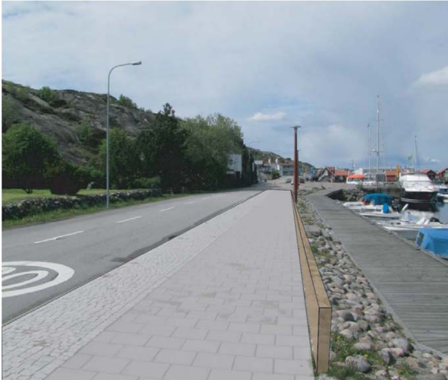
Figur 20 Principskiss av förslaget där befintlig gångbana föreslås skyltas som gång- och cykelbana samt breddas ev till 2,5 m. Eventuellt anläggs ett räcke (enligt gällande regler) för fotgängarnas och cyklisternas säkerhet. Foto taget västerut på Södra Hamnen.
