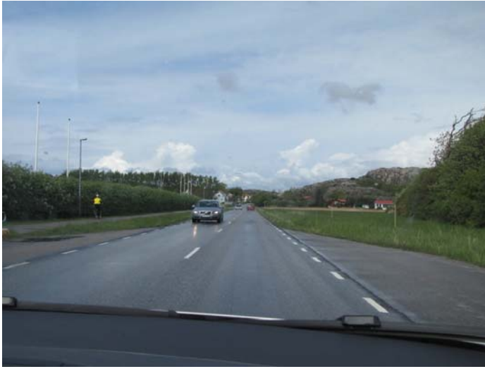
Figur 10 Befintlig gång- och cykelväg på västra sidan om Hamngatan. Fotot taget norrut på Hamngatan.
