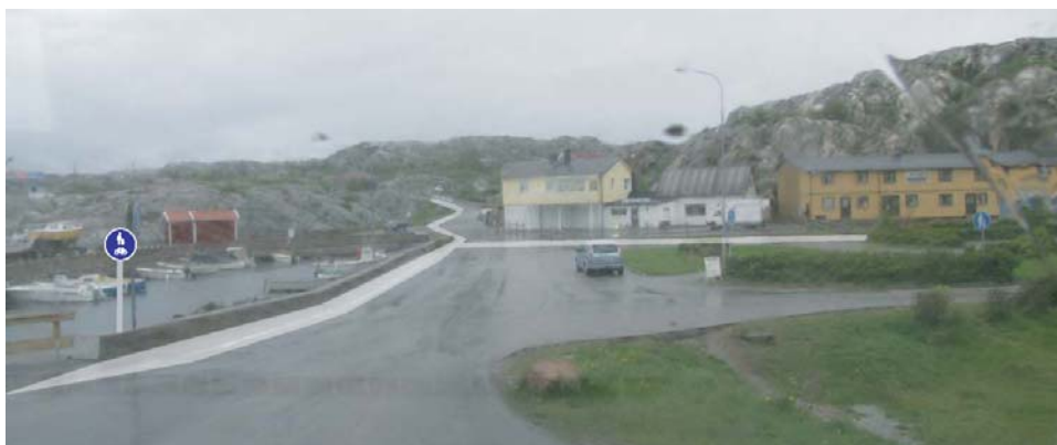
Figur 32 Ny gång- och cykelväg utmed Strandvägen från korsningen Hamngatan/Strandvägen till Malaga. Cykelväg österut förbi Oceanum. Ej reell placering av skylt. Foto taget norrut på Strandvägen.
