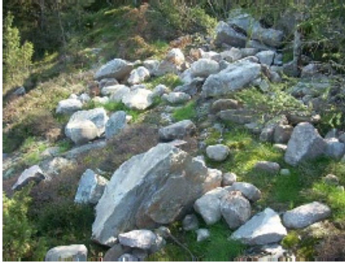
Foto 8.2 Lösa block och stenar i bergslänt, södra området.
