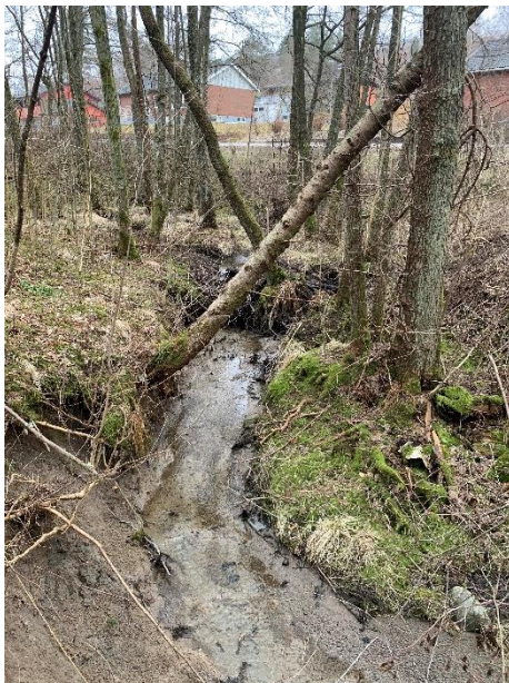
Bild 2. Pågående erosionsförlopp längs bäckens sidor
