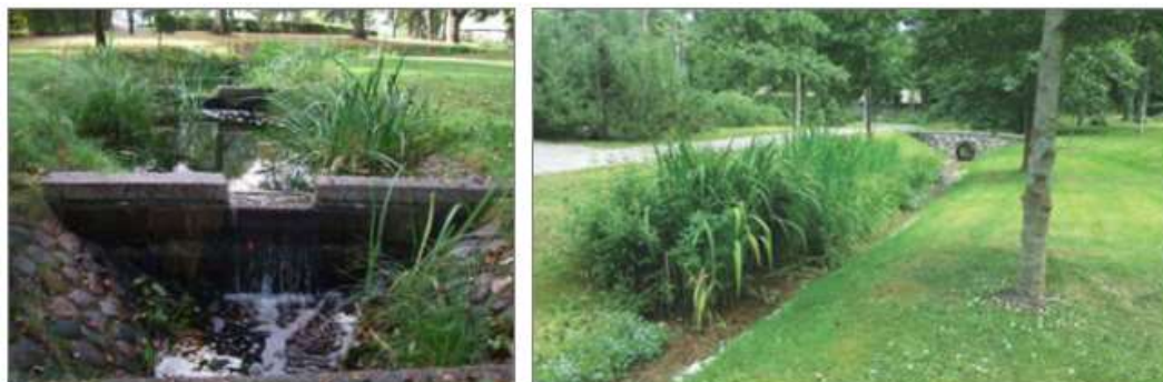
Figur 25. Till vänster: svackdike med dämman. Till höger: svackdike med erosionsskyddande växtlighet. Foto: Veg Tech.
